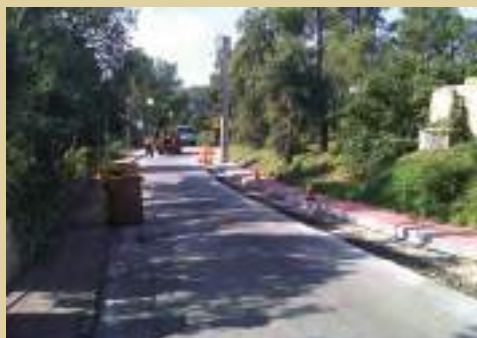
Millora la vorera i paviment d'asfalt al carrer de la Miranda
