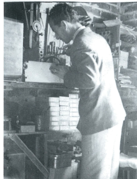
Antonio Aguirre Martín a la sala de màquines del far. 1950 aprox. (Col·lecció Rosina Lozano, AMP).
